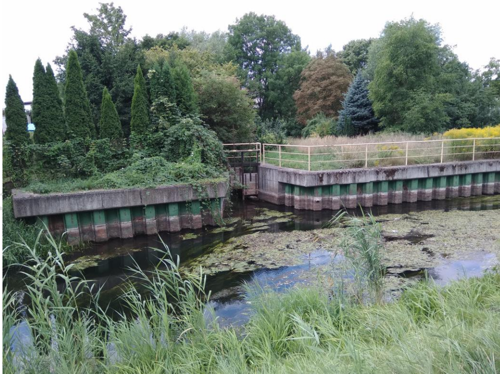
Fot.3 Wlot do kanału ulgi w rejonie hotelu „Bończa”.
