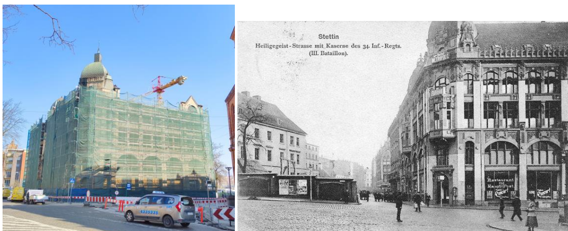
Fot. 5 - 6 Budynek starej drukarni - stan obecny (marzec 2022, materiały własne) oraz w latach przedwojennych (źródło: www.sedina.pl )
