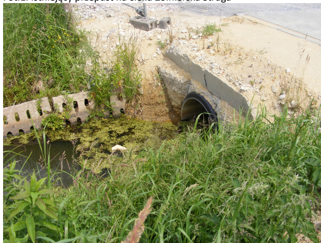
Fot.1. Istniejący przepust na cieku Żołnierska Struga
