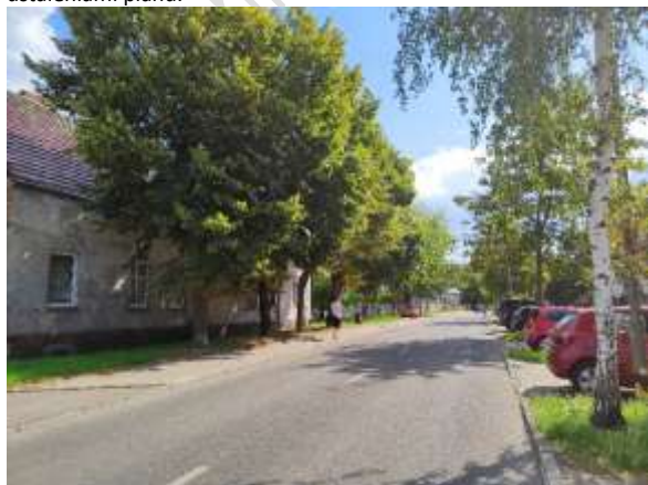
Fot. 7. Zabudowa przy ul. Chłopskiej 26; budynek chroniony ustaleniami planu.
