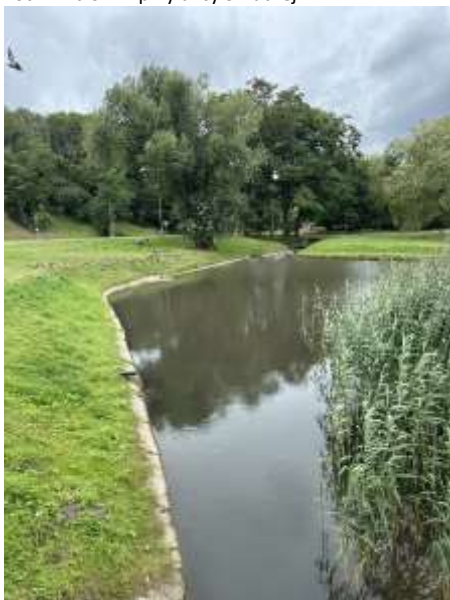
Fot. 4. Zbiornik przy ulicy Smutnej
